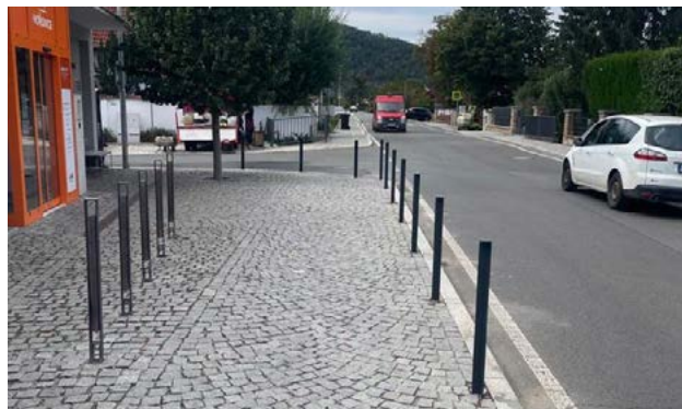
Nové sloupky zamezují parkování na chodníku před prodejnou COOP.
