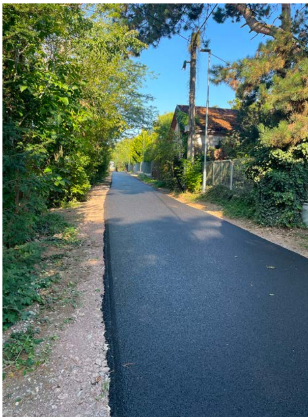
Asfaltový povrch ulice Pod Vinicí
