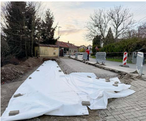
Bílý pruh tkaniny je položen pod budoucím chodníkem.
