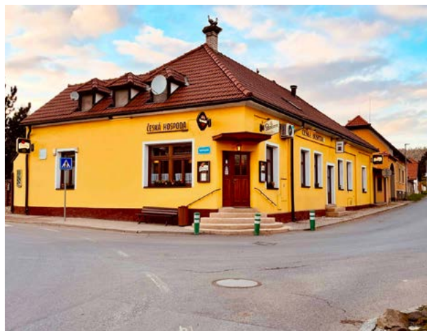
Problematické místo pro chodce u vstupu do restaurace Česká hospoda.
