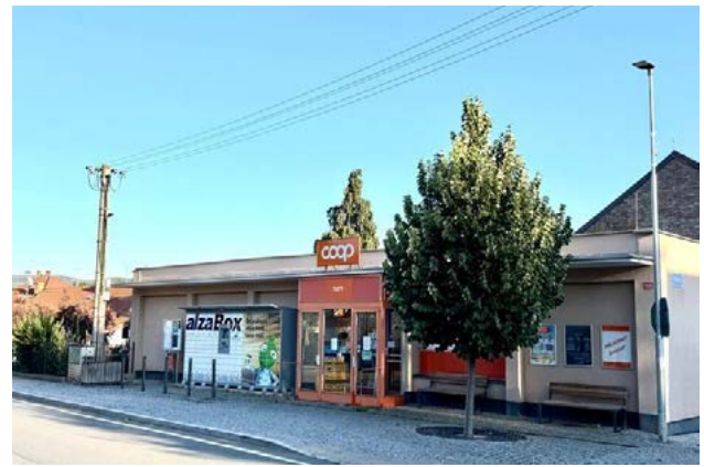
Elektrické vedení u prodejny COOP bude přemístěno pod zem
