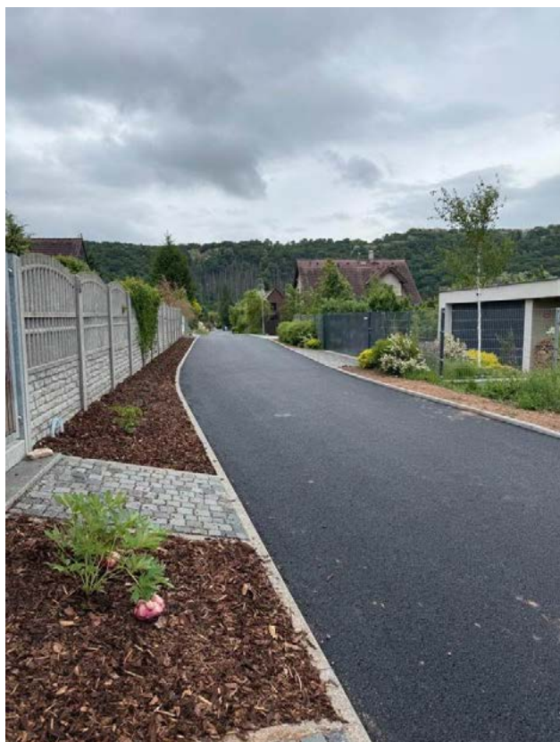
Cesta ke mateřské škole těsně před dokončením
