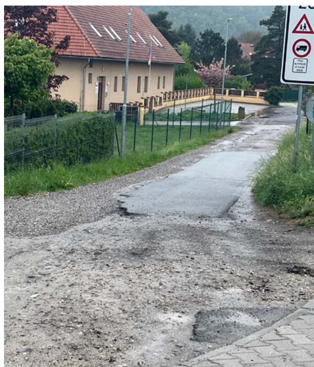
Ulice Luční od křižovatky s ulicí Na Paloučku ke školce dostane nový povrch
