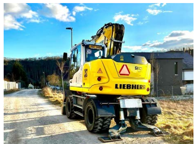
Rekonstrukce ulice Na Paloučku
