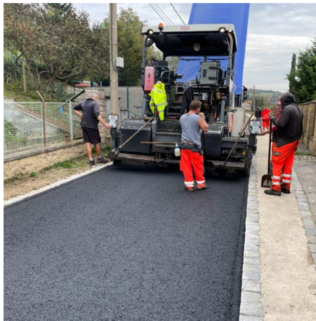
Ilustrační foto – rekonstrukce ulice Pod Svahem
