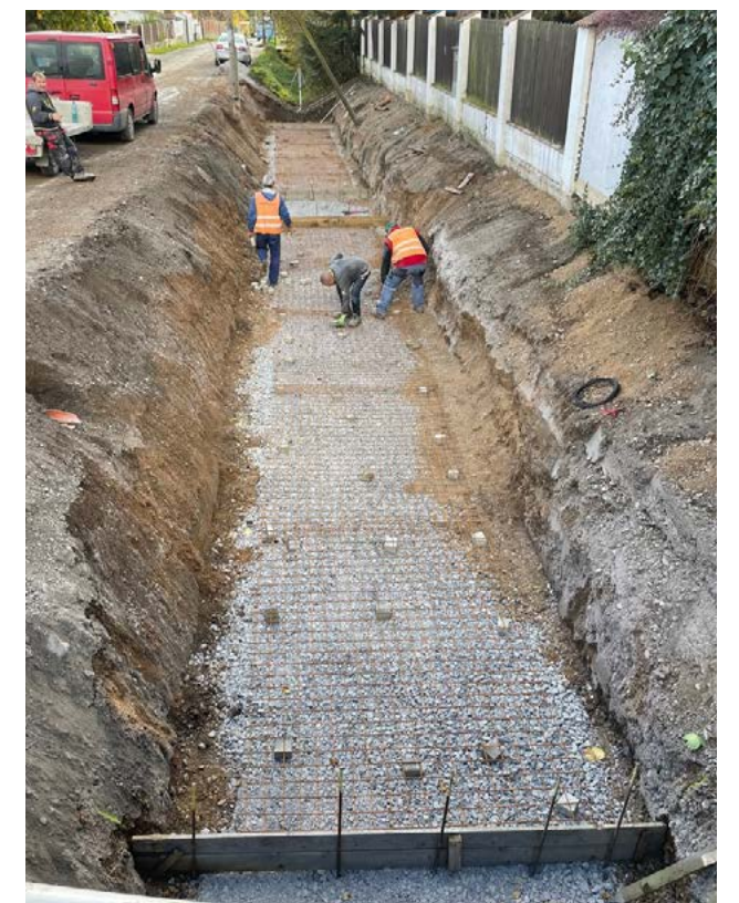
Založení stavby parkoviště u COOP
