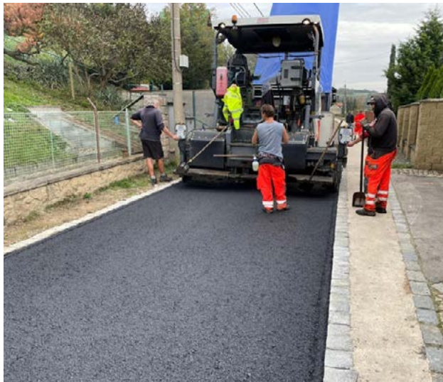
Pokládání první vrstvy asfaltu v ulici Pod Svahem
