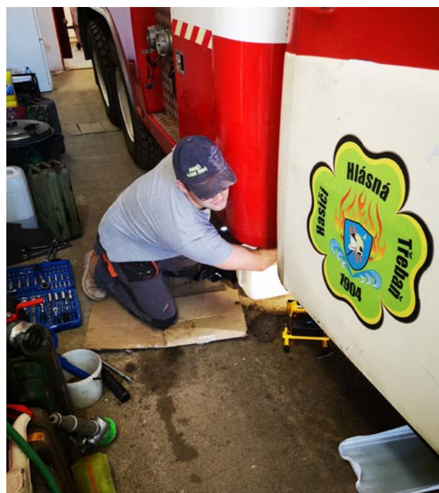
Jan Šesták pracuje na opravě Tatry v hasičárně
