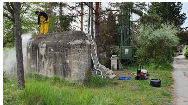
Odstraňování letitých nánosů tlakovým mytím
