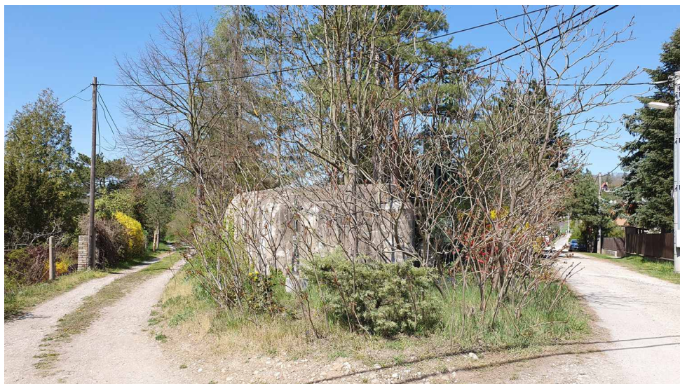
Pohled na bunkr před zahájením prací
