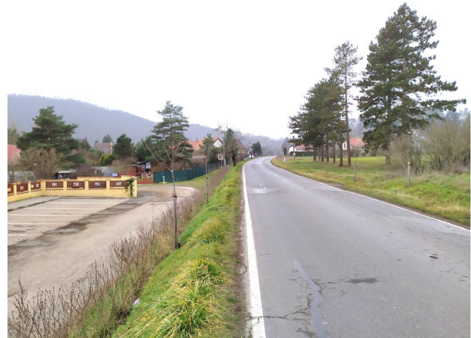
Obrázek 1 – Problémový úsek Karlštejnská
