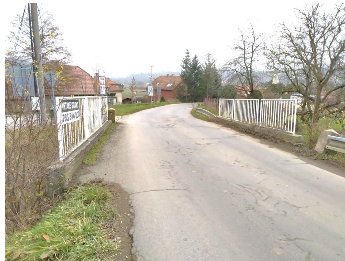
Obrázek 26 – Úzký můstek v ulici Mořinská (pohled směr Mořina)
