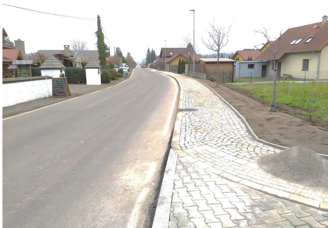
Obrázek 25 – Nový chodník v ulici Karlštejnská (pohled směr Rovina)
